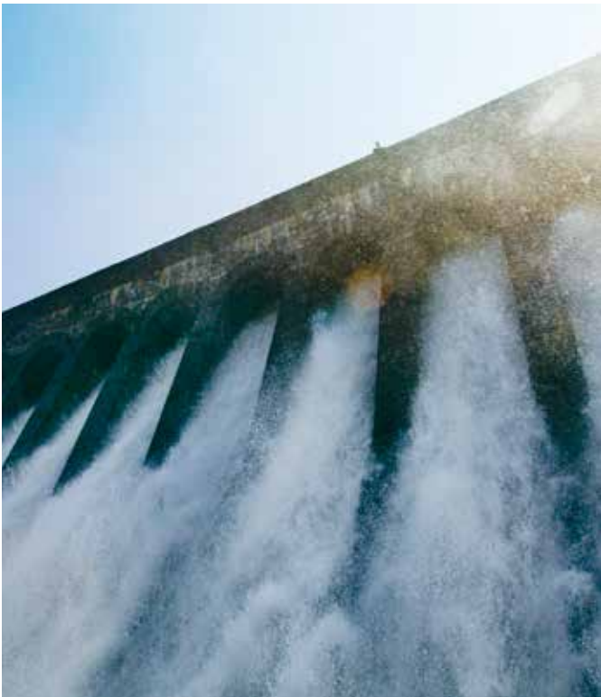
Hochwasserüberlauf der Möhnetalsperre
